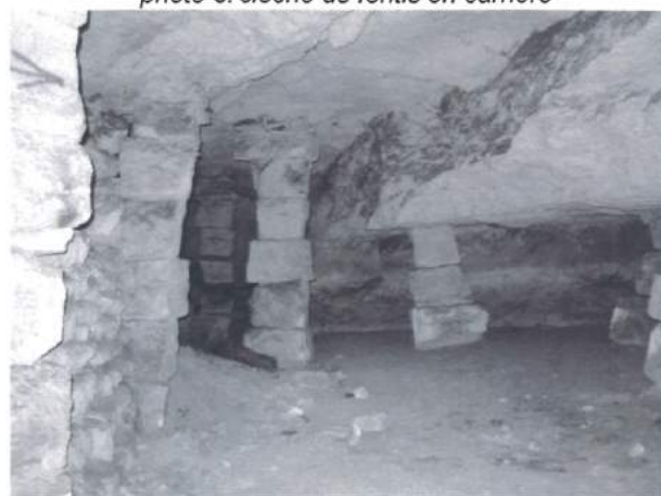
photo 10: vue des galeries avec piliers à bras
