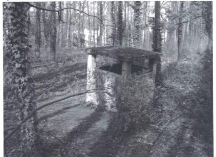
photo 14: Vue du puits de la carrière au niveau du parc
