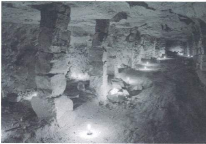
photo 5: Galerie avec piliers à bras
