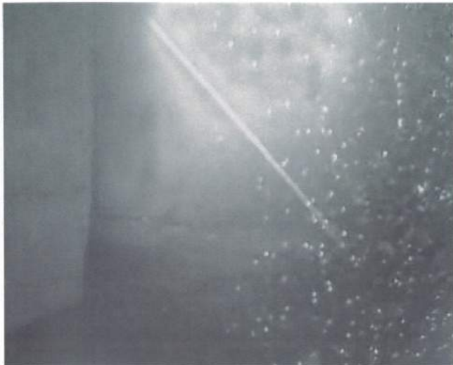
photo 21: Photo d'une galerie inondée
