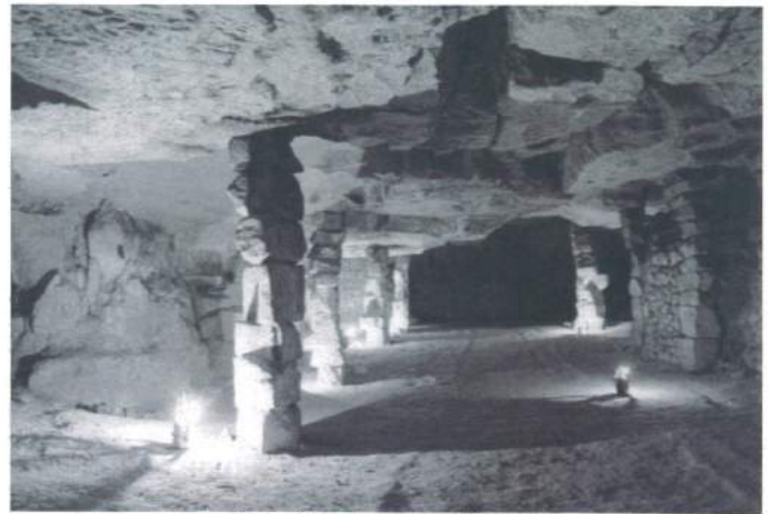
photo 6: Galerie avec piliers à bras
